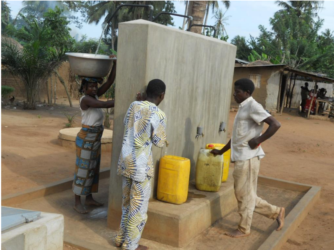
Image d' une Borne Fontaine à puisage multiple (3 Robinet bas et 3 Robinets hauts)
